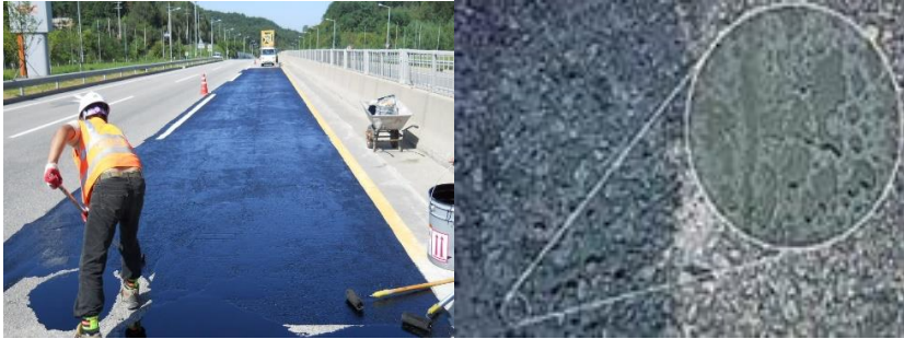
Рис. 4. Нанесення шару просочування «ASP Chem-Crete»
