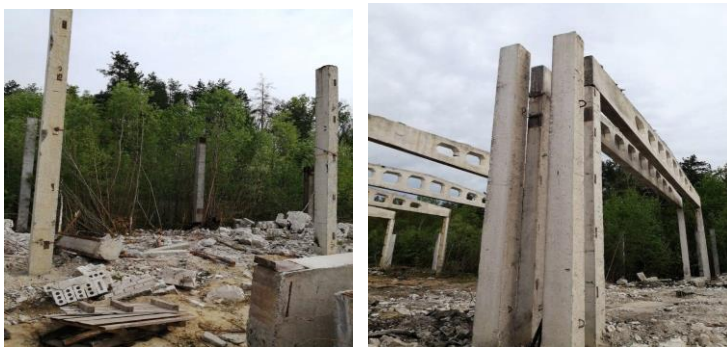
Рис. 1. Елементи каркасу в стадії демонтажу
