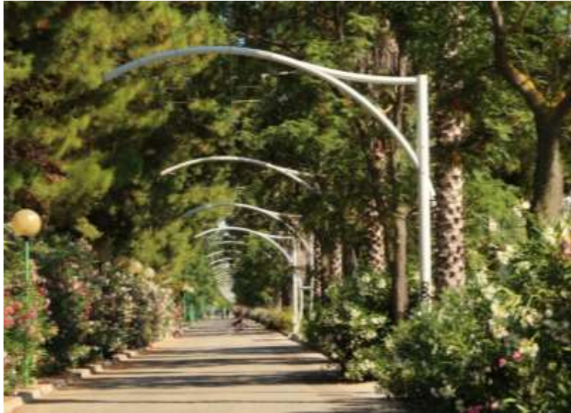
Fig. 7 – Trolleybus catherway, fot. Mikołaj Bartłomiejczyk (Pescara, Italien).
