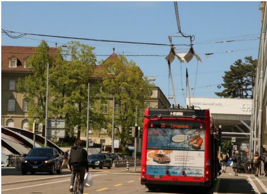
Fig 3 – Automatic connection to trolleybus catenary, fot. Mikołaj Bartłomiejczyk (Bern, Schweiz).
